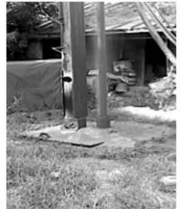
霊山地区での井戸掘削
