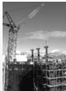
2005年11月15日 大型クレーンで鉄骨の積み上げ
