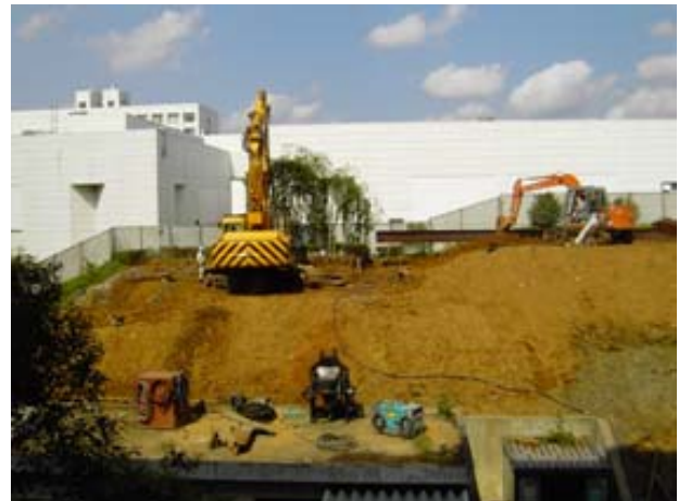
基礎工事が始まった8月8日
