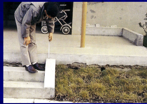
完成後1年で、団地の入り口に16cmの落差 (「日本の平野」平凡社より)
