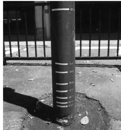
鉄管のしるしが、 当時の地面 (「日本の平野」平凡社より)
