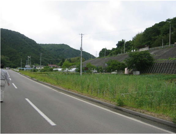
梁川地区（阿武隈川右岸）
