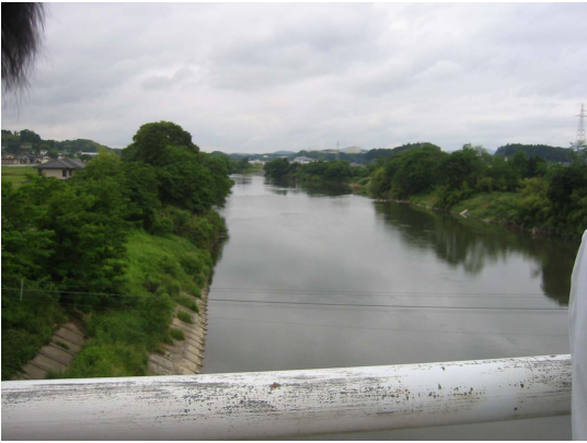
安達地区の無堤部
