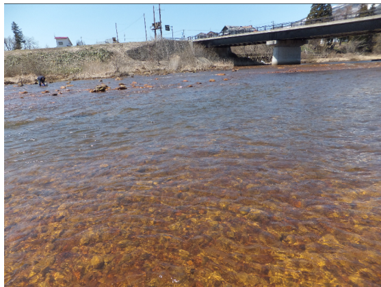
長瀬川橋下流
